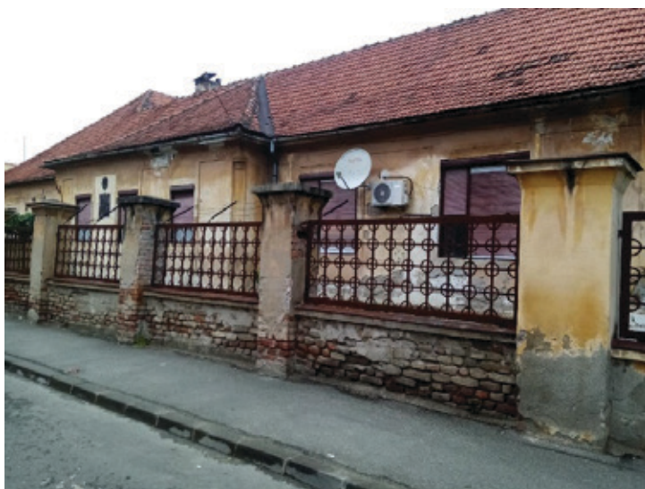
Слика 3. Главна улична фасада Текелијине куће; садање стање
