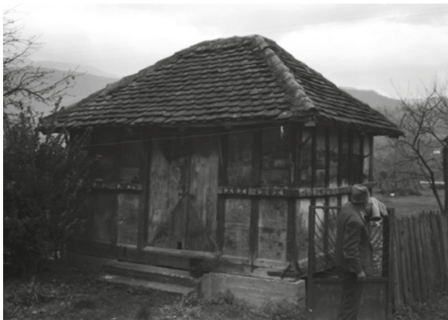
Прилој 18. Магаза у дрвеном скелету, испуном од брвана, четвороводним кровом на темељима од тесаног камена (делом замењен бетоном)
