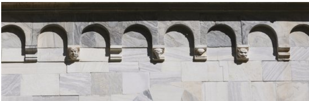
Сл. 2. Студеница, Богородичина црква, конзоле аркадног фриза јужне фасаде, западни травеј (фото: Миодраг Марковић)
