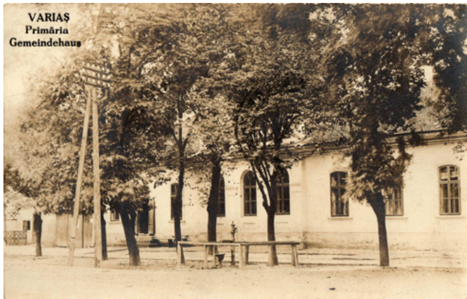
Тип. бр. XXI. Варјаш, око 1924. год. Зграда општине.
